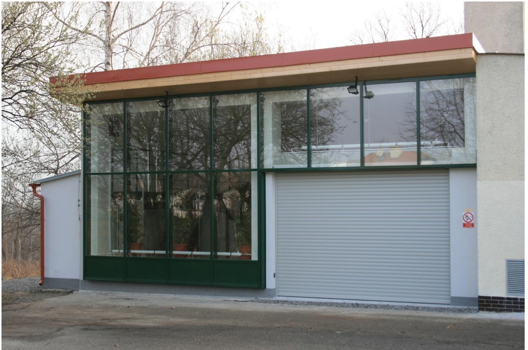
Pohled na Laboratoř palivových článků se skladem vodíku.
